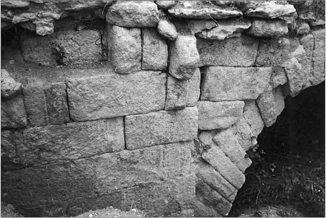
Lam. 3. Puente sobre el barranco de la Frontera. Estribo sur
