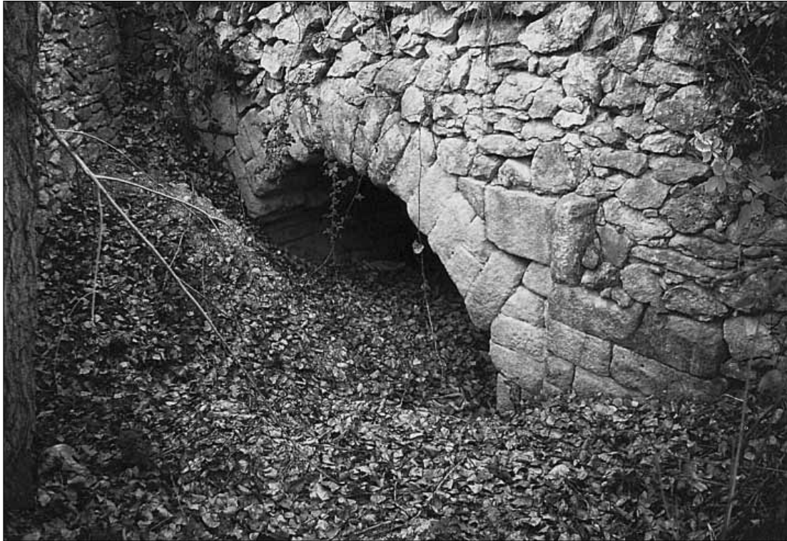
Lam. 5. Puente sobre el barranco de Perinos. Frente sur
