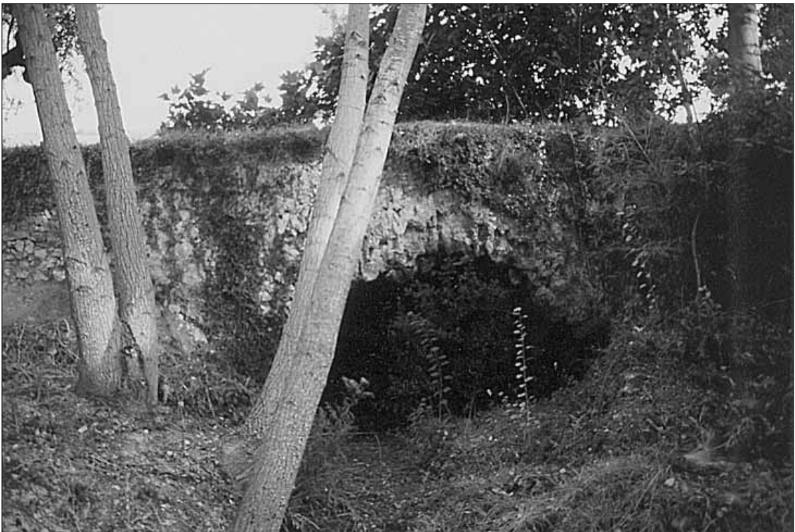
Lam. 8. Puente sobre el barranco del Canyaret. Frente norte
