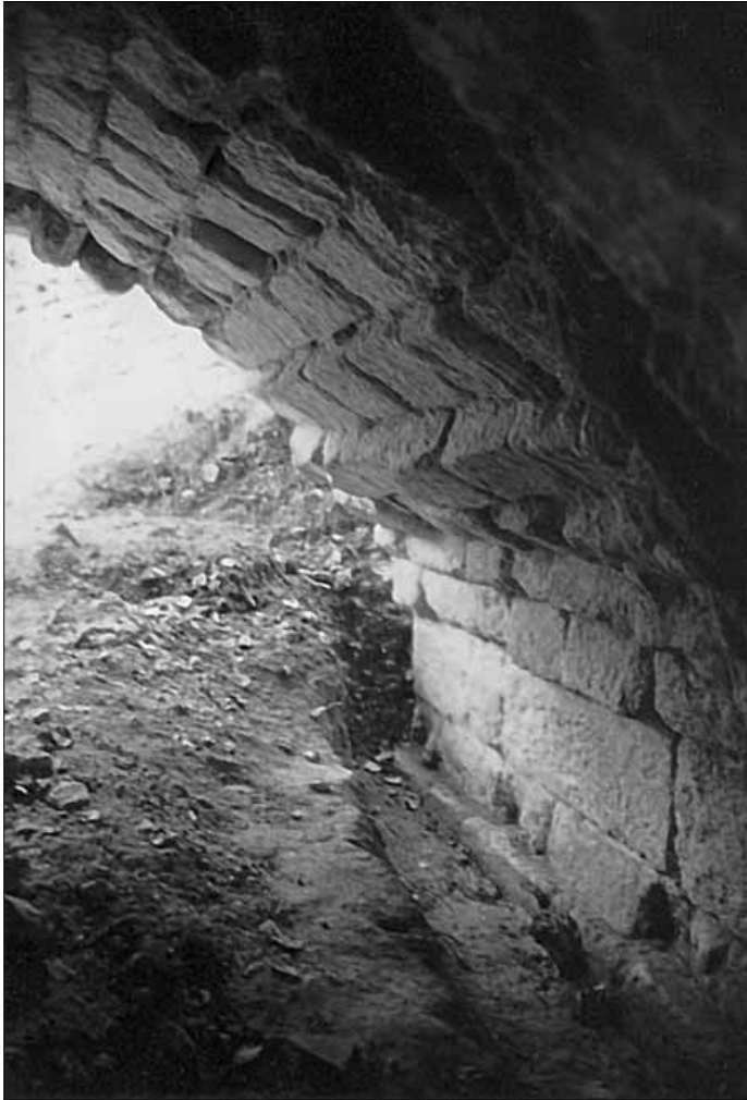
Lam. 7. Puente sobre el baranco de Perinos. Vista parcial del intradós
