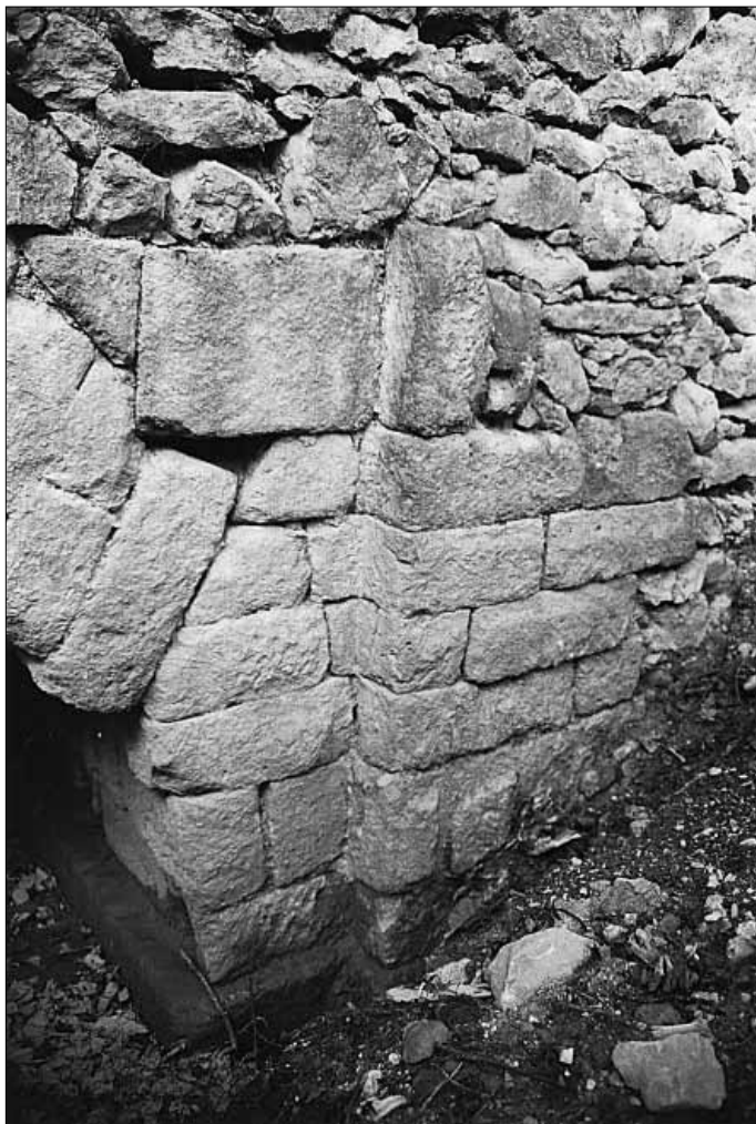
Lam. 6. Puente sobre el barranco de Perinos. Estribo este
