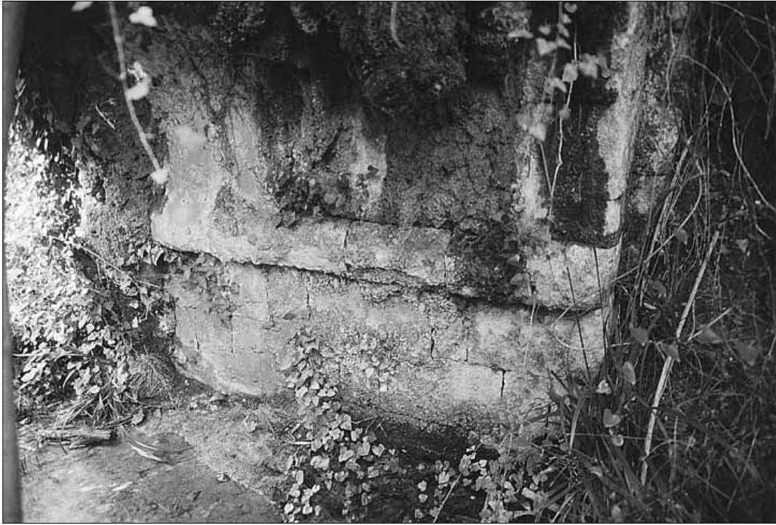
Lam. 9. Puente sobre el barranco del Canyaret. Estribo e imposta del costado este
