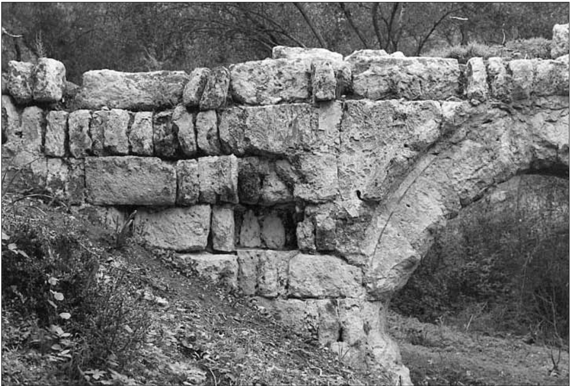
Lam. 4. Puente-Acueducto de Valdepuentes; Medina Azahara; Córdoba. Estribo oeste
