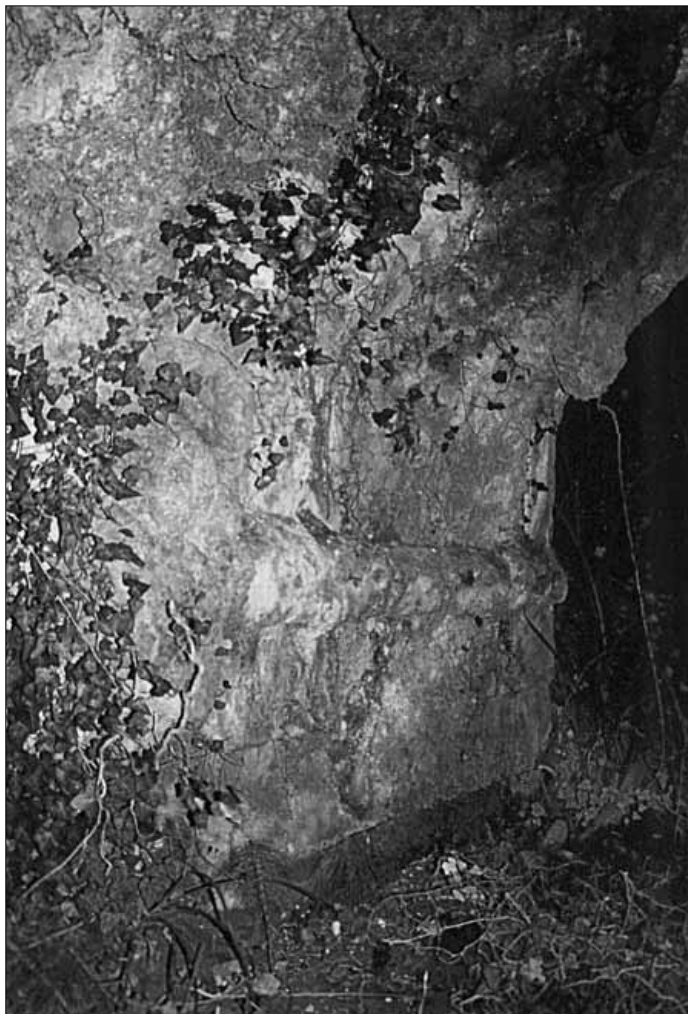
Lam. 10. Puente sobre el barranco del Canyaret. Costado este
