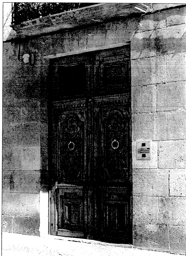
Detalle fachada; en su día fue Cuartel de Bocarent. Calle del Batlle.
