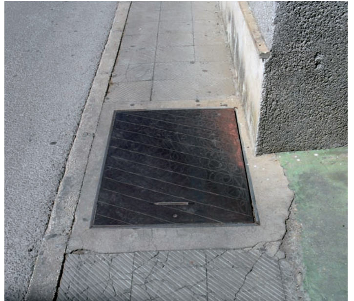
Boca d'eixida del Refugi del Repunxó.
